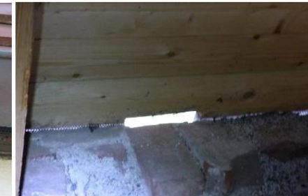
Für Fledermäuse belassene Einflugöffnung im Lüftungsgitter von außen und innen gesehen
