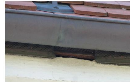
Für Fledermäuse belassene Einflugöffnung im Lüftungsgitter von außen und innen gesehen
