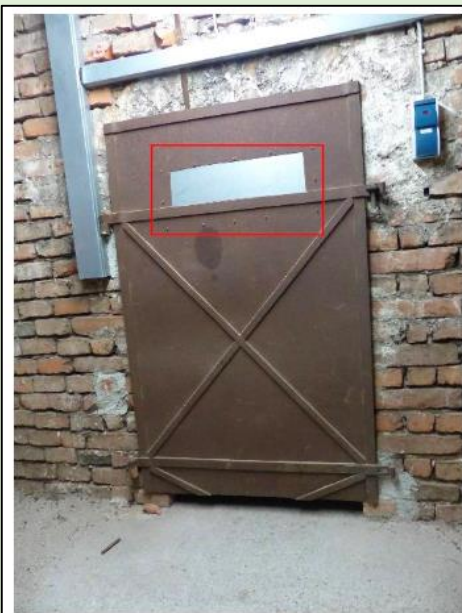
Verbindung Dach- Turm herstellen: Blecheinsparung durch Tür herausnehmen
