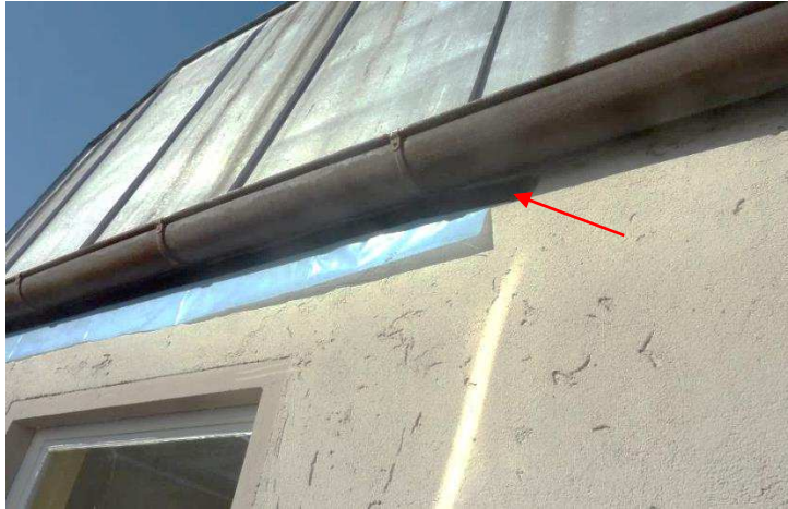
Abb. 4: Folienstreifen unter dem Ein-/Ausflug (Quartier zwischen Dachrinne und Wand) als glatte Kletterbarriere, mit Klebeband (roter Pfeil) an der Wand befestigt. Im Anschluss wird oberhalb des Quartierspaltes die zweite, weiter herabhängende Folie befestigt, hier noch nicht angebracht (Bild A. Lustig).
