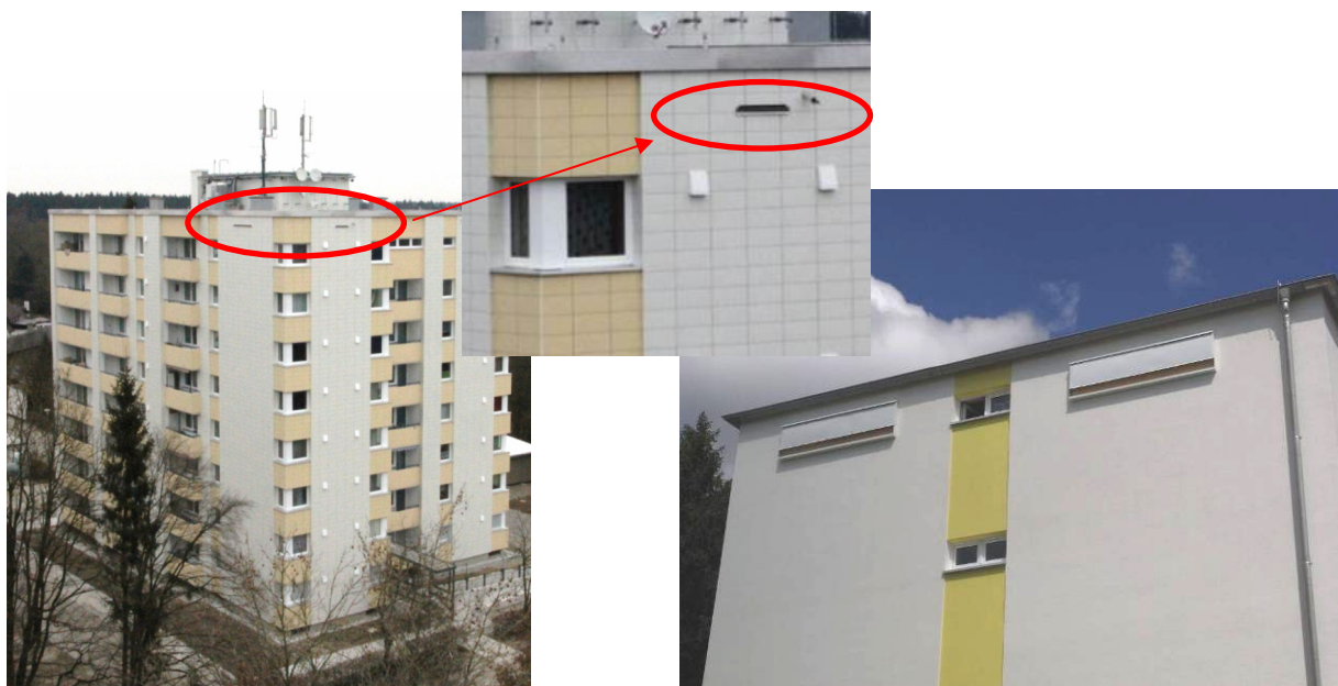
Abendsegler-Ersatzquartiere in Waldkraiburg: Einbau in eine Fassade (links), Anbringung von Kästen (rechts). (Fotos: A. Zahn)
